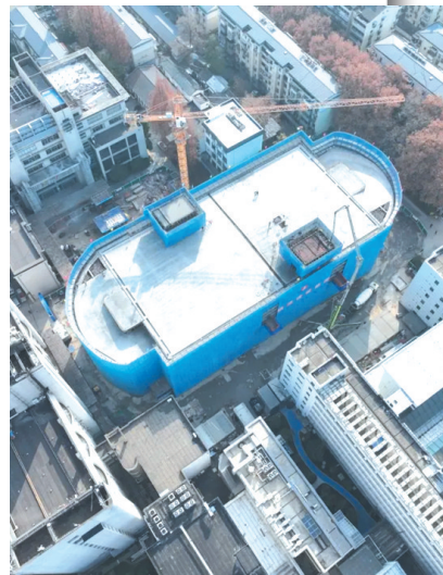
停车楼项目主体结构已封顶，预计今年6月底投入使用
